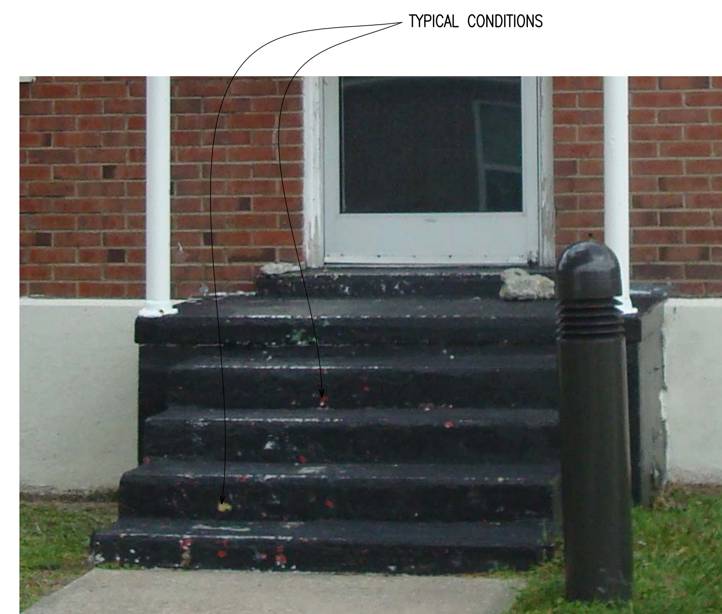
7 PHOTOGRAPH A-201A-901 EXISTING SIDE PORCH N.T.S.
