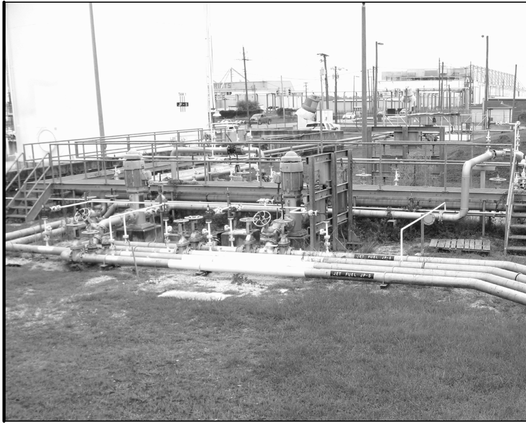
PUMP PAD OVERVIEW D1 MD401
